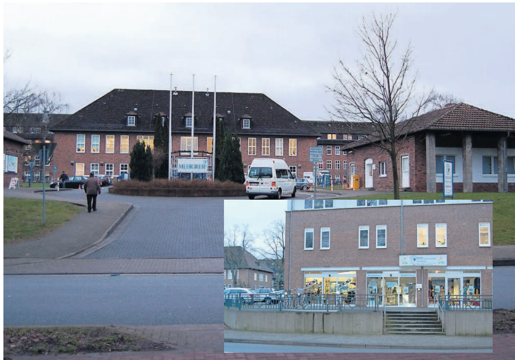
Auf dem Gelände der Medigreif GmbH hat OT aktiv eine Werkstatt und ein Sanitätshaus übernommen. In den nächsten Wochen bekommt das Sanitätshaus ein noch neues Gesicht und wird komplett saniert. Fotos/Montage: Cornelia Waldheim
